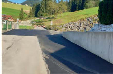
Länge von ca. 50 lfm abgefräst und teils auch der Unterbau bearbeitet. Die Feinplanie wurde komplett erneuert und auch die Oberflächenentwässerung saniert und ein neuer Schacht gesetzt.
