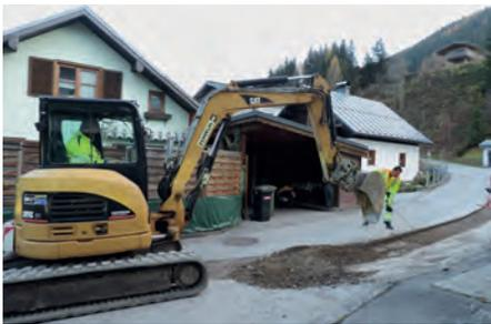
Darum wurde Mitte November nur eine Reparaturschicht Asphalt als Überbrückung für den Winter asphaltiert.
